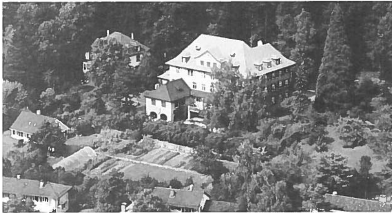
Schule im Grünen, das Haus Sonnenberg und seine Gartenanlage
